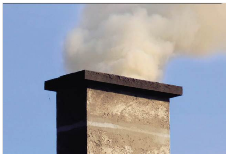
Slika 13; Temnejši ali temen gost dim na vrhu dimnika je pokazatelj zelo slabega zgorevanja (Vir: www.richtigheizen.at )
