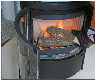
Slika 9; Pri ponovni naložitvi se praviloma doda eno ali dve poleni na žerjavico (Vir: www.heimwerkerlexikon.selbermachen.de )
