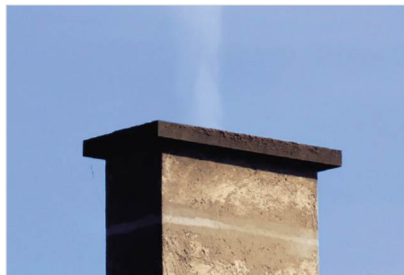
Slika 14; Svetel – neviden dim, razen pare je pokazatelj dobrega zgorevanja, za strokovno presojo so sicer potrebne meritve emisiji
